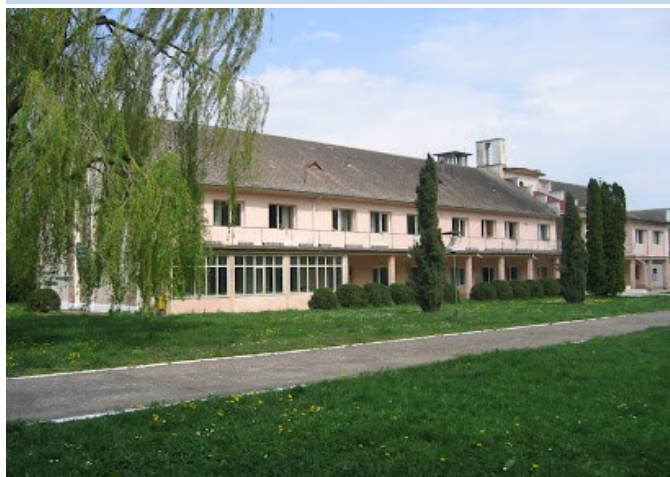
Foto: captură Site
