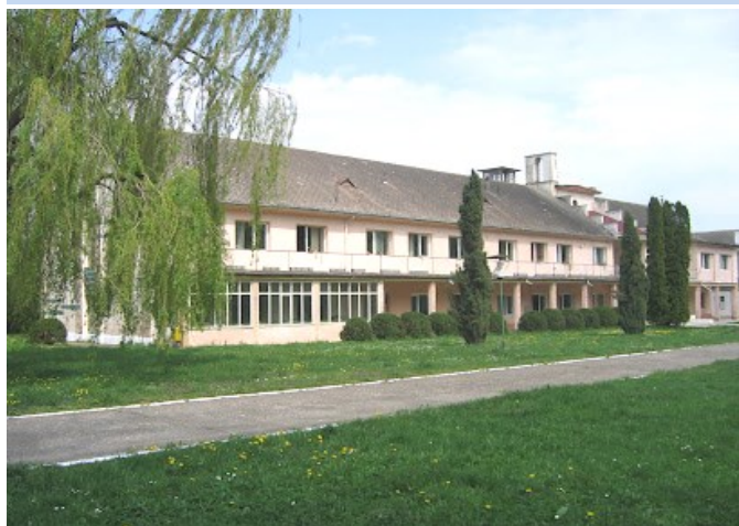
Foto: captură Site
