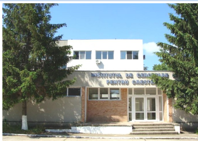
Foto: captură Site
