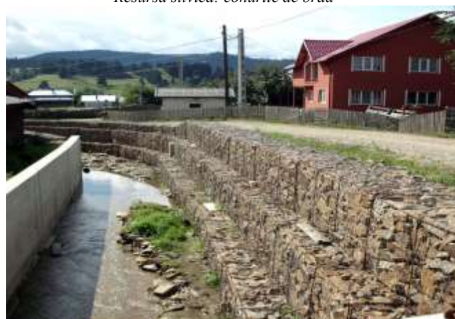
Amenajarea râului: zid de sprijin și albie curată
